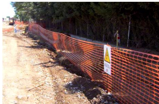
Acotar y señalizar la presencia de conducciones eléctricas enterradas.
